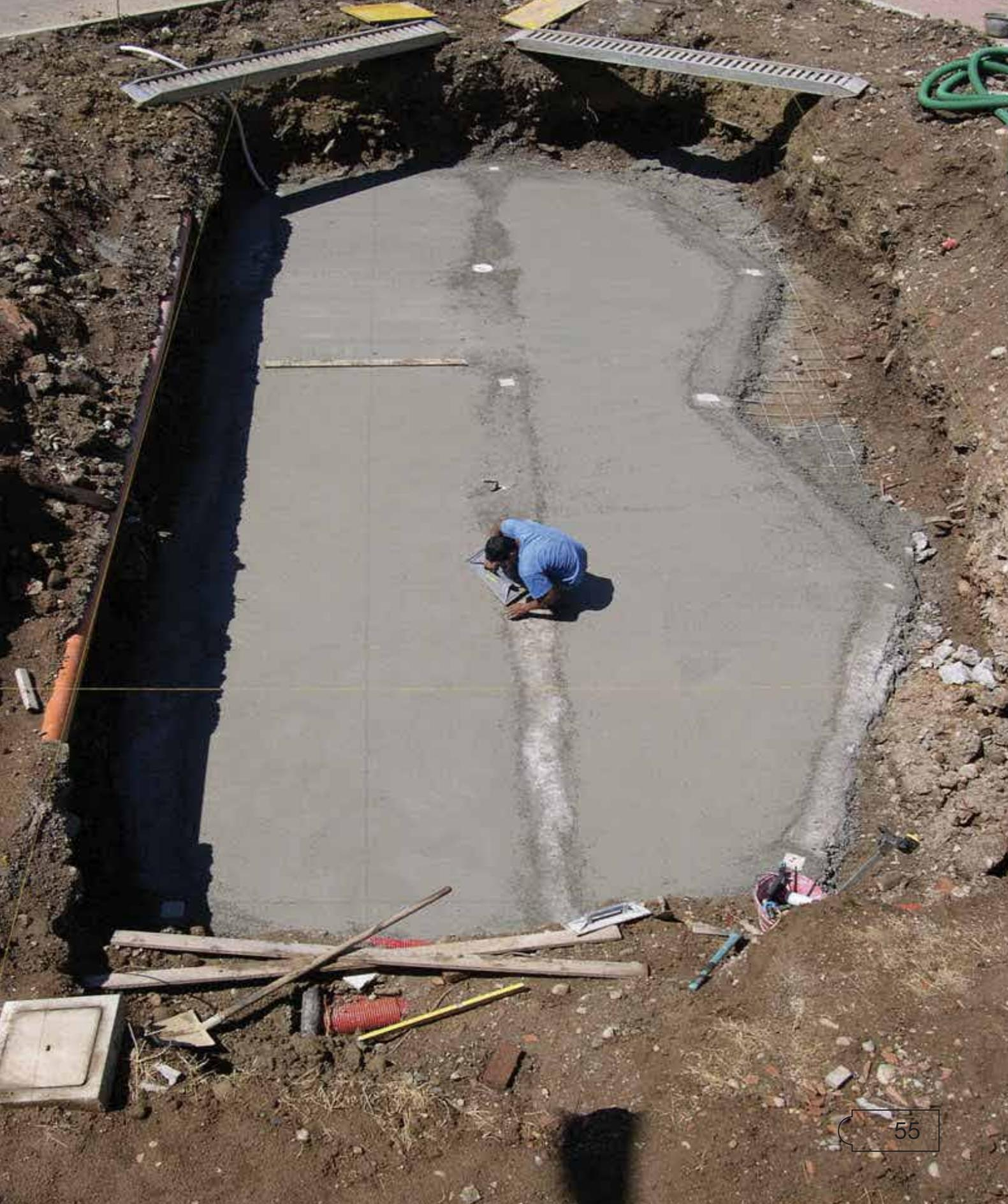
1. La piscina viene tracciata sul terreno e si realizza lo scavo secondo le dimensioni indicate; si getta il fondo in cemento.
